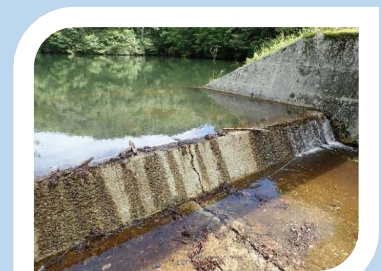
洪水吐のひび割れから漏水している状態
