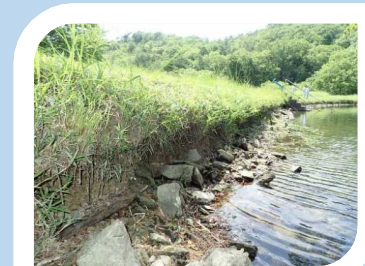
上流法面が侵食されている状態
