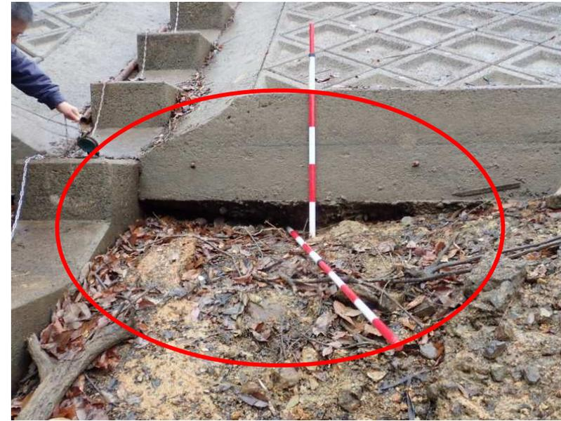
遮水層のクラック(アスファルトフェーシング等表面遮水の場合)
