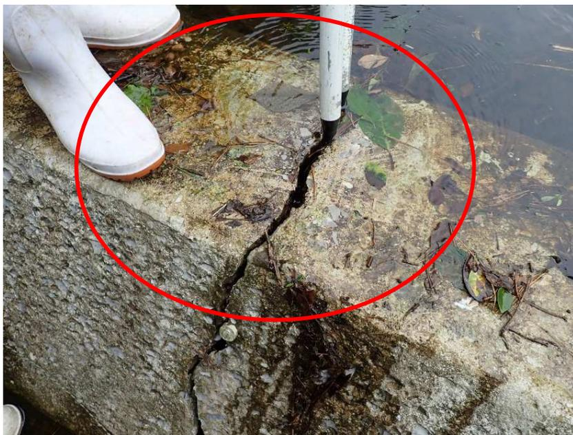
放水路側面の陥没
