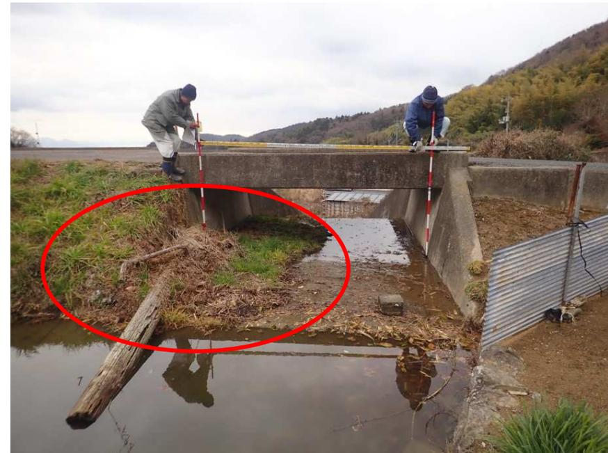
貯水量を増やす目的で、洪水吐流入部に土のうを積んだり堰板をするのは、洪水吐の流下能力を低下させることになります。洪水時にため池から溢れ出た水が堤体を越流した場合、決壊する危険がありますので、絶対に行ってははいけません。
