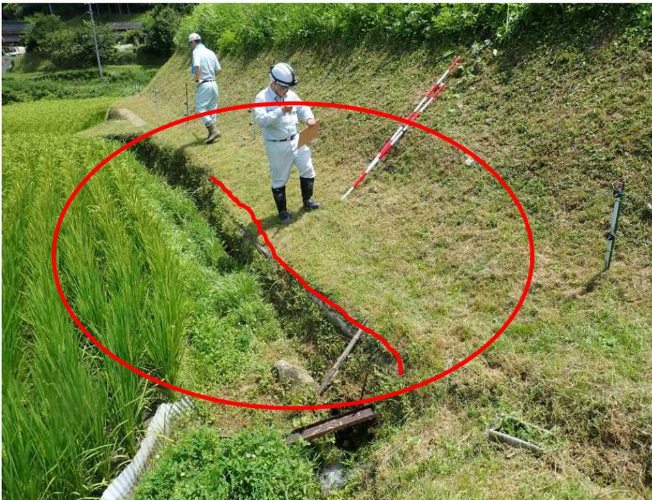
堤体下流法面の沈下
