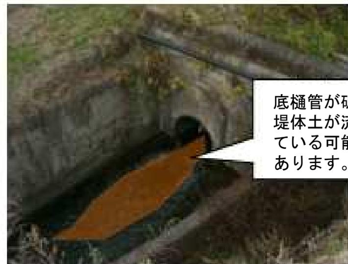
底樋管が破損し、堤体土が流出している可能性があります。
