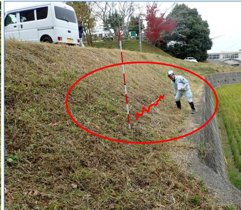
堤体下流法尻からのしみ出し漏水
