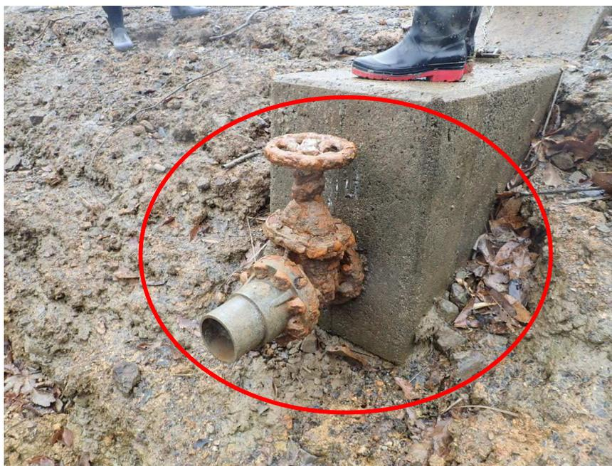
底樋土砂吐ゲートの劣化
