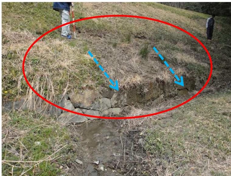
堤体下流法面の中段からのパイピング漏水
