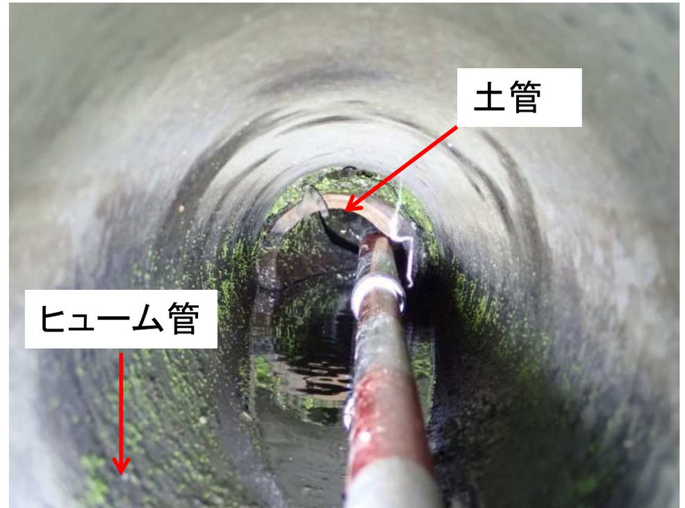
未改修ため池で、出口管がヒューム管や塩ビ管の場合は、底樋管を継足している可能性があるため、接続部の不具合により漏水している場合もあります。
