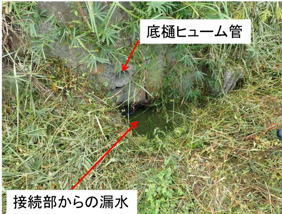
接続部の陥没
